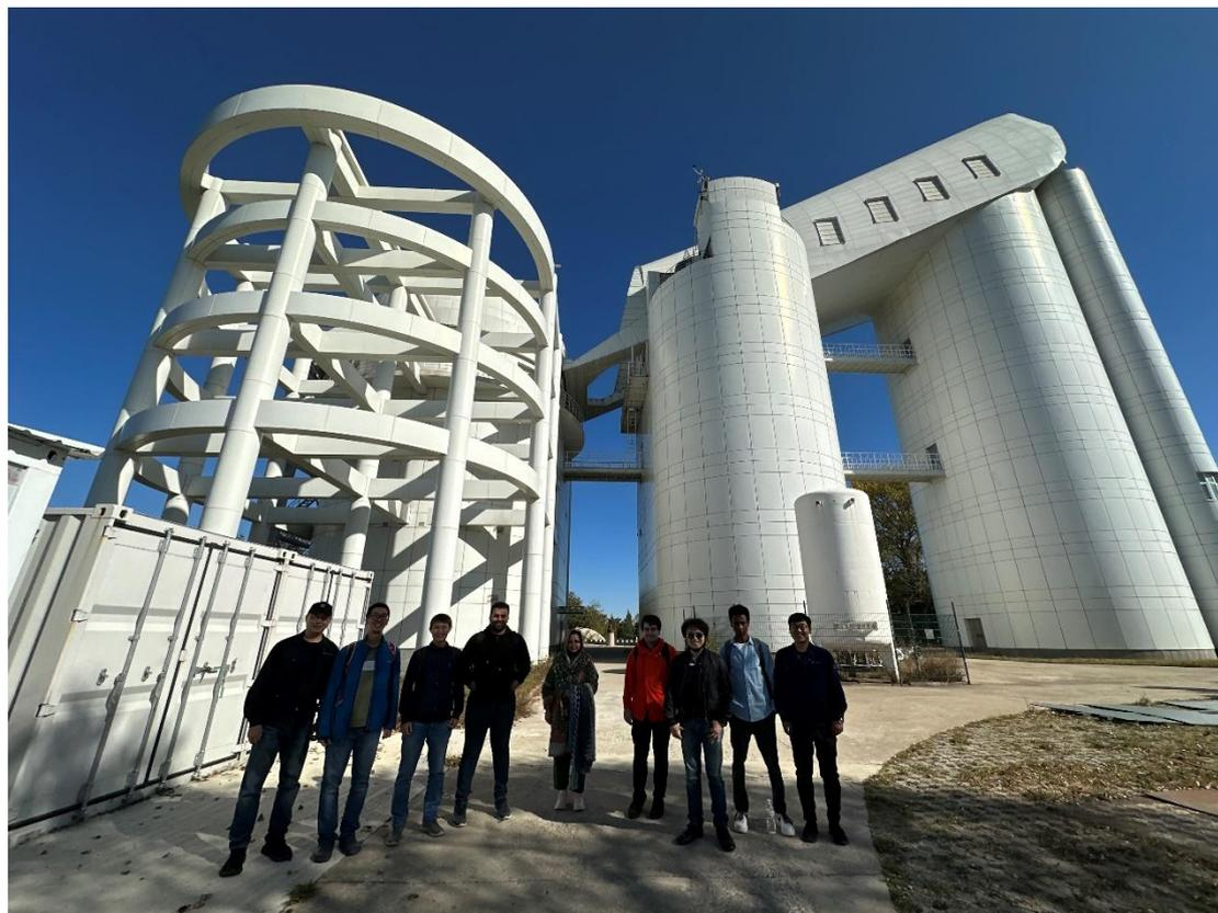
郭守敬望远镜 (LAMOST)，全名大天区面积多目标光纤光谱天文望远镜，于 2008 年建成，并于 2009 年通过验收，是国家重大科学工程。LAMOST 的有效通光口径达 4 米，并可在拥有 5 度视场的同时在焦面上同时放置 4000 根光纤，可同时对 4000 个天体进行光谱观测。2012 年 9 月，LAMOST 开始正式巡天。2017 年 6 月，LAMOST 完成了第一期光谱巡天，获得光谱数量远超当时全世界光谱巡天项目之和。2018 年 6 月，LAMOST 成为世界上首个光谱数量超千万的光谱巡天项目。这些数据为银河系、河外星系、宇宙学的研究都做出了重大贡献。
